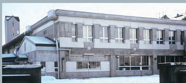
県立会津養護学校 O.K-S-K-N 福島県会津若松市
