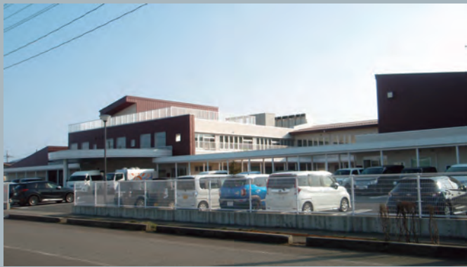
障がい者支援施設鶴峰園 O.K-S-K-N 山形県鶴岡市
