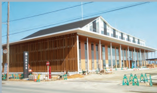
川西町役場庁舎 O.K-S-K-N 山形県川西町
