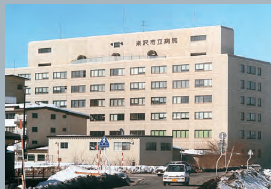
米沢市立病院 O.K-S-K-N 山形県米沢市
